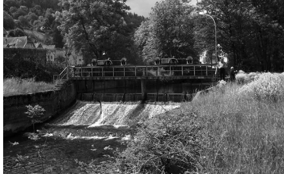
La centrale du Leymel est la plus élevée des trois centrales cofinancées par Abendrot à Munster (F) et se situe en dehors de l'aire industrielle des Manufactures Hartmann.
