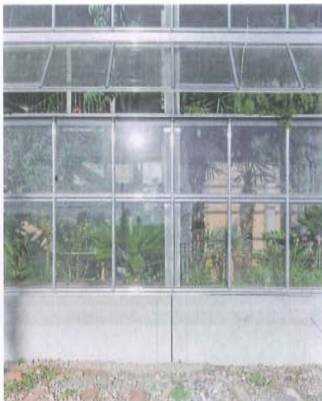
Was hinter dieser Gewächshausfassade in Winterthur schimmert, macht nouglerig.
