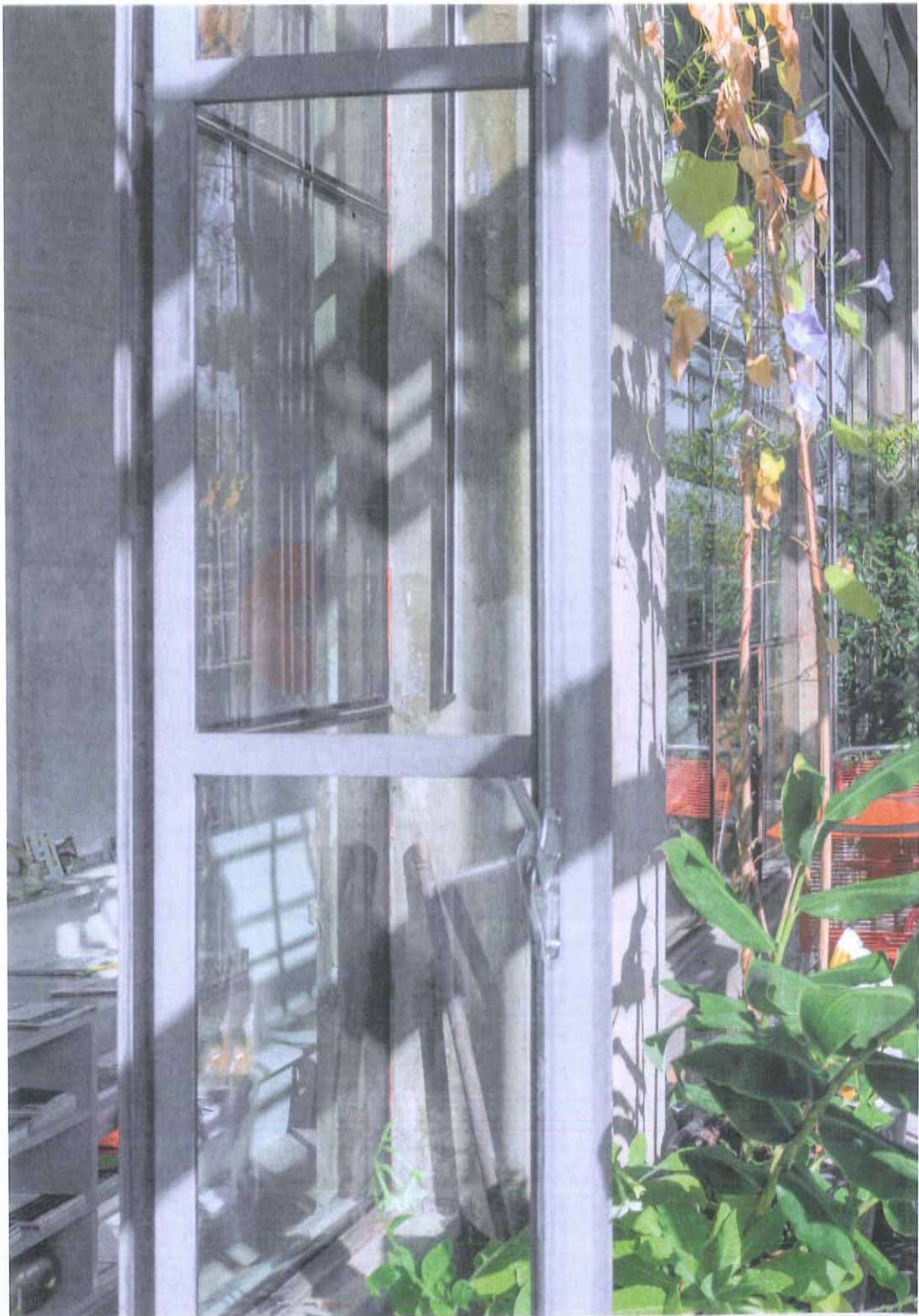
Umgebaute Halle 181 auf dem Lagerplatz in Winterthur: Eine neue Schicht dient als Schall- und Kältepuffer, aber auch als Aufenthaltsraum und botanisches Labor.
