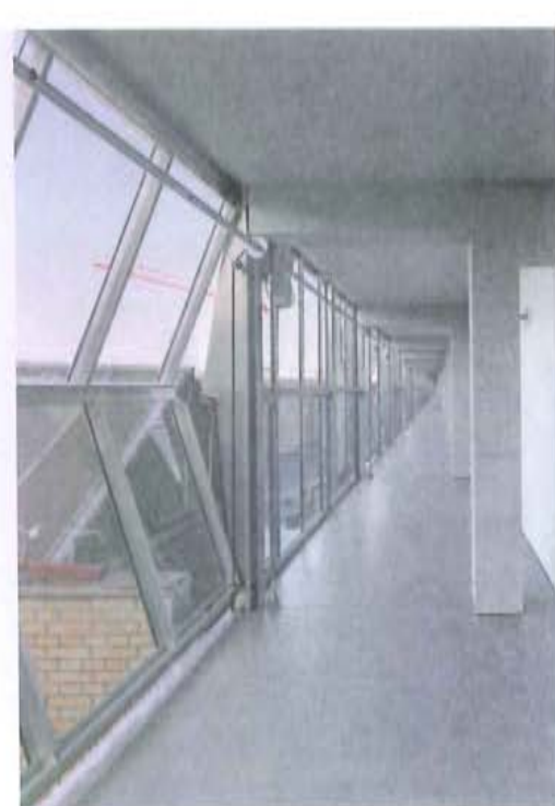
Der Gang im 2. Obergeschoss ist knapp über dem alten Hallendach abgehängt.
